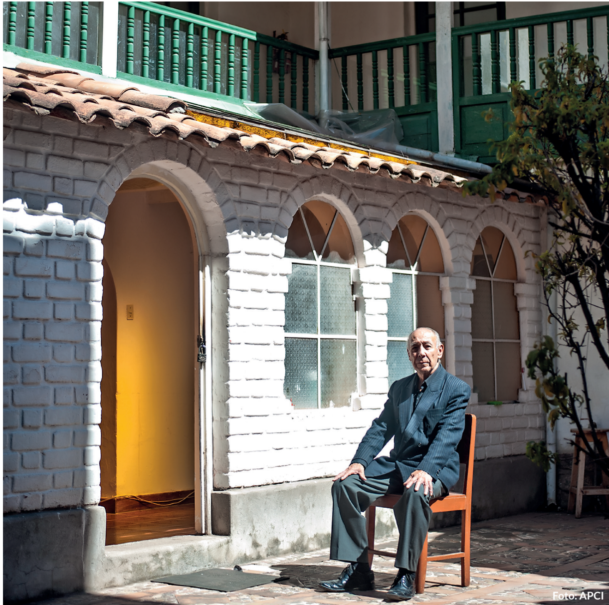
Casona del señor Manuel Linares, ubicada en el centro histórico del Cusco, habilitada con la cooperación privada
