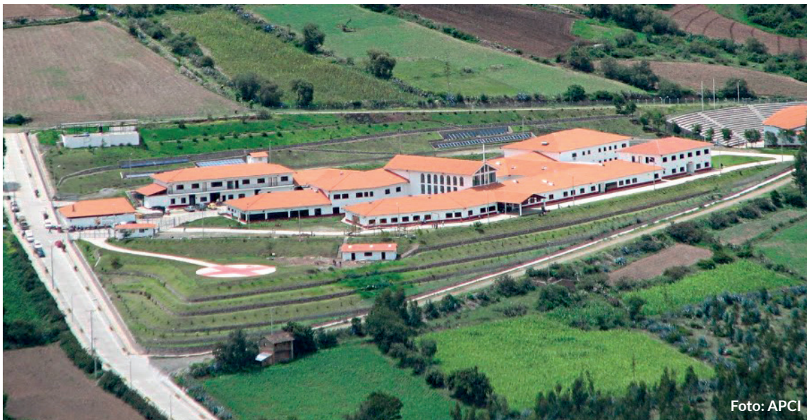
Vista aérea del Hospital - Intervención “DIOSPI SUYANA 201”5”
